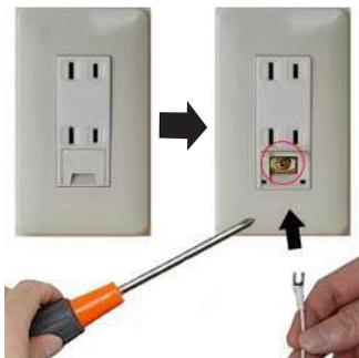
ネジをドライバーで緩めます。Y字端子側を差込み、ネジを締めて接続します。
